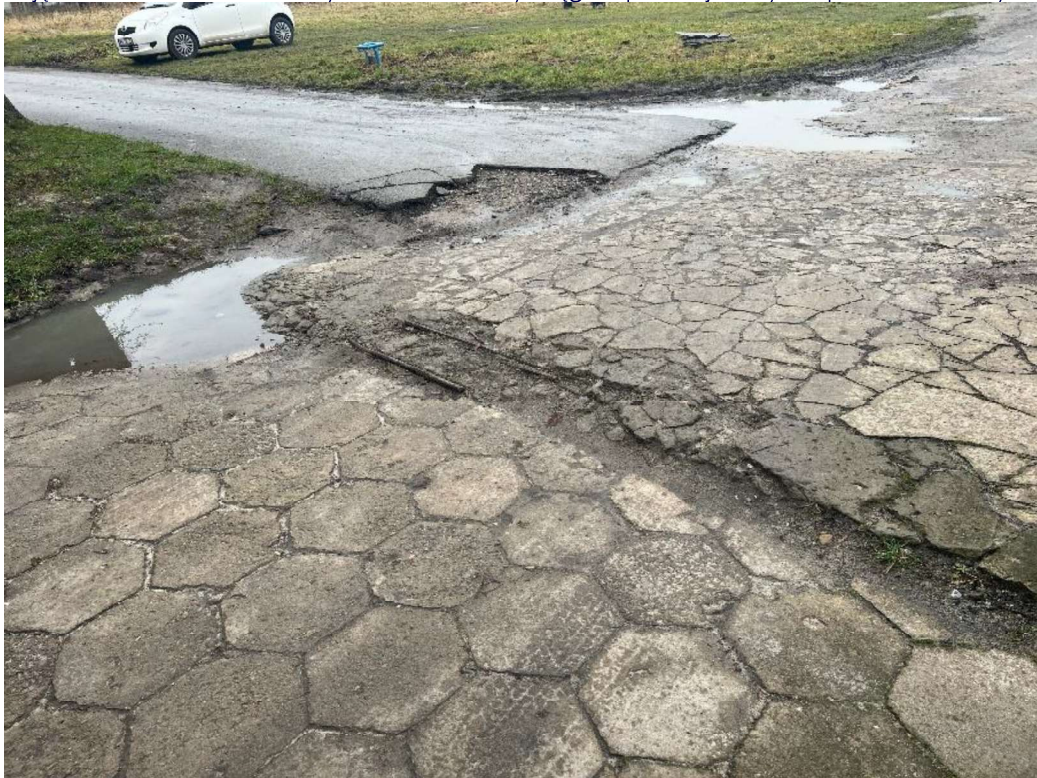
Zdjęcie 13. Ul. Chełmska – zły stan techniczny ciągów pieszo-jezdnych i placów, bariery architektoniczne.
