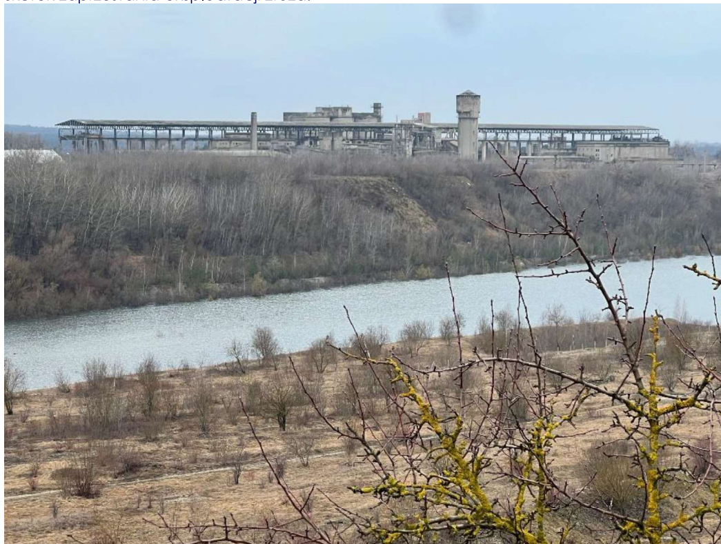
Zdjęcie 16. Zabudowa cementowni oraz teren po kopalni margla (wyrobisko) wypiętniający się wodą na skutek zaprzestania eksploatacji złoża.
