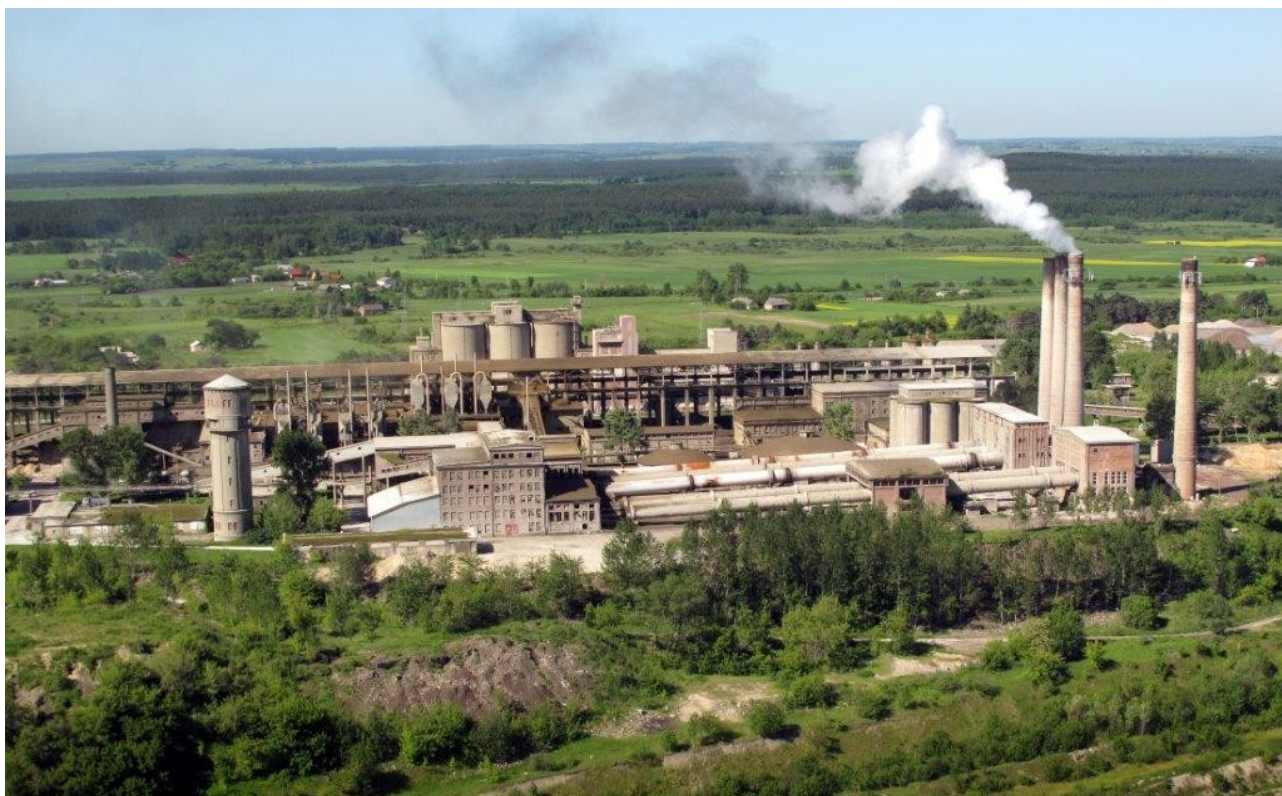
Rys. 7 Grupa Ożarów S.A. Zakład Cementownia Rejowiec
